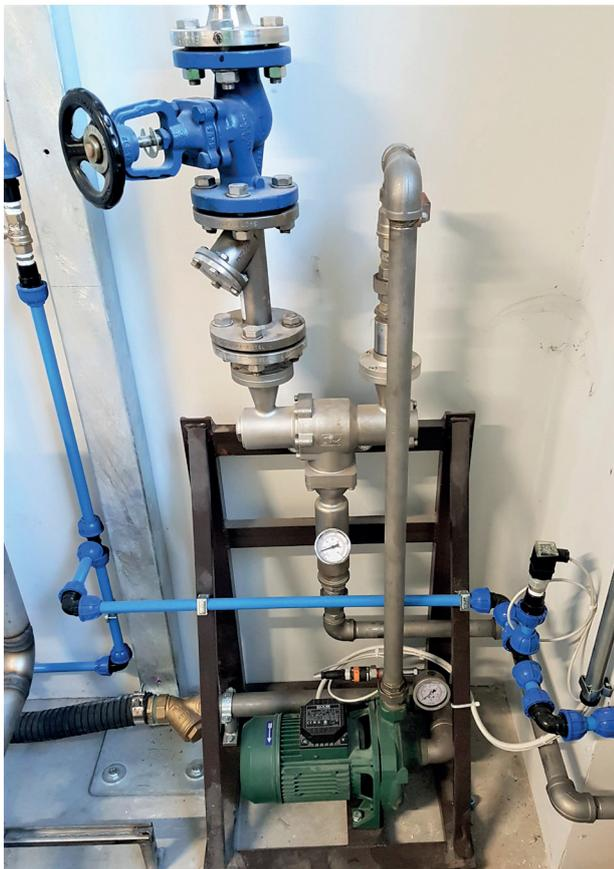
Insieme dati da caldaia di produzione acqua calda primaria, completa di circuito primario e secondario collegati a scambiatori a piastre inox, per la produzione di acqua calda a servizio di impianti di lavaggio IBC, Chassis e lance manuali in numero considerevole.
