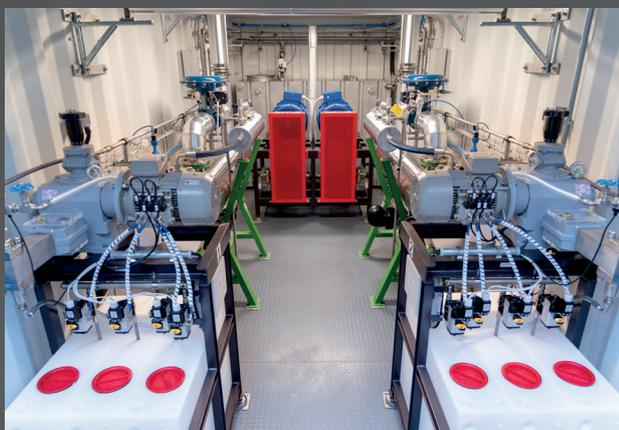
Nel caso non fossero reperibili locali per la installazione della centrale termica e di pompaggio, **OMZ predispone Container da 20 piedi**, per lo scopo, completamente coibentati, di classe 0 di resistenza al fuoco, completi di impianto di illuminazione e di prese di aerazione.
